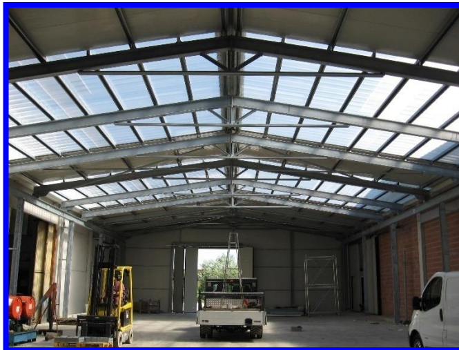
EDIFICIO IN ACCIAIO
