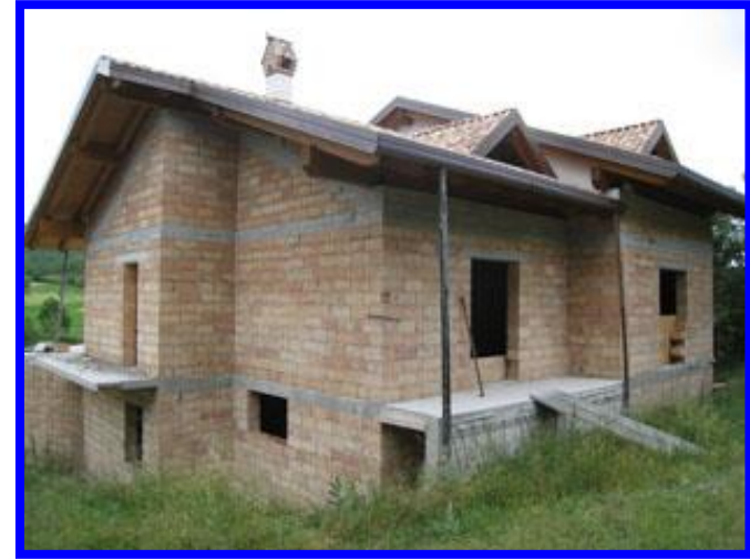
EDIFICIO IN MURATURA
