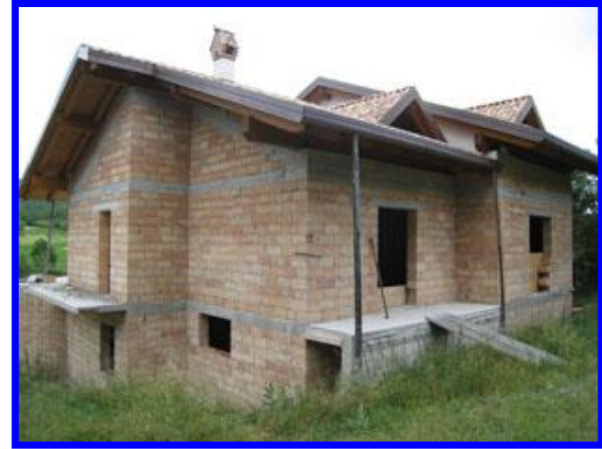
EDIFICIO IN MURATURA
