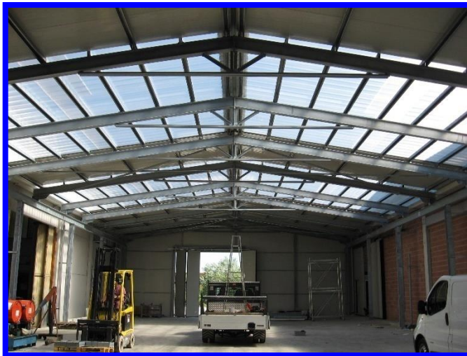
EDIFICIO IN ACCIAIO
